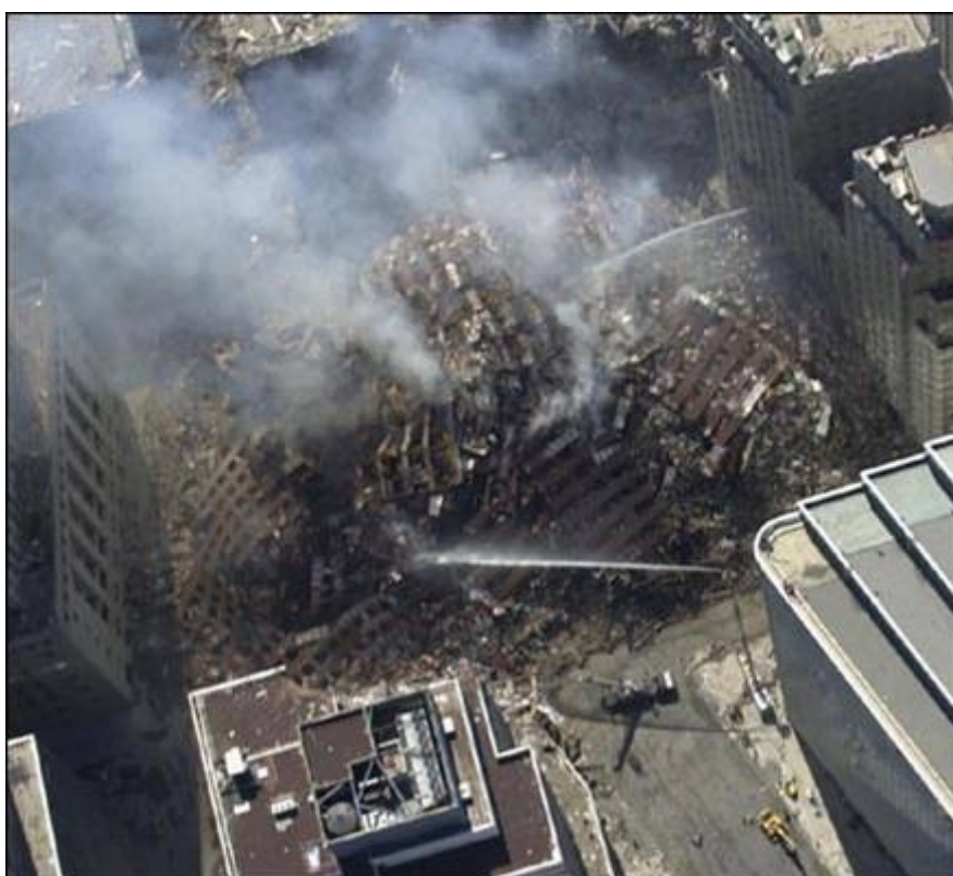
Il WTC 7 completamente crollato, sul proprio ingombro.
